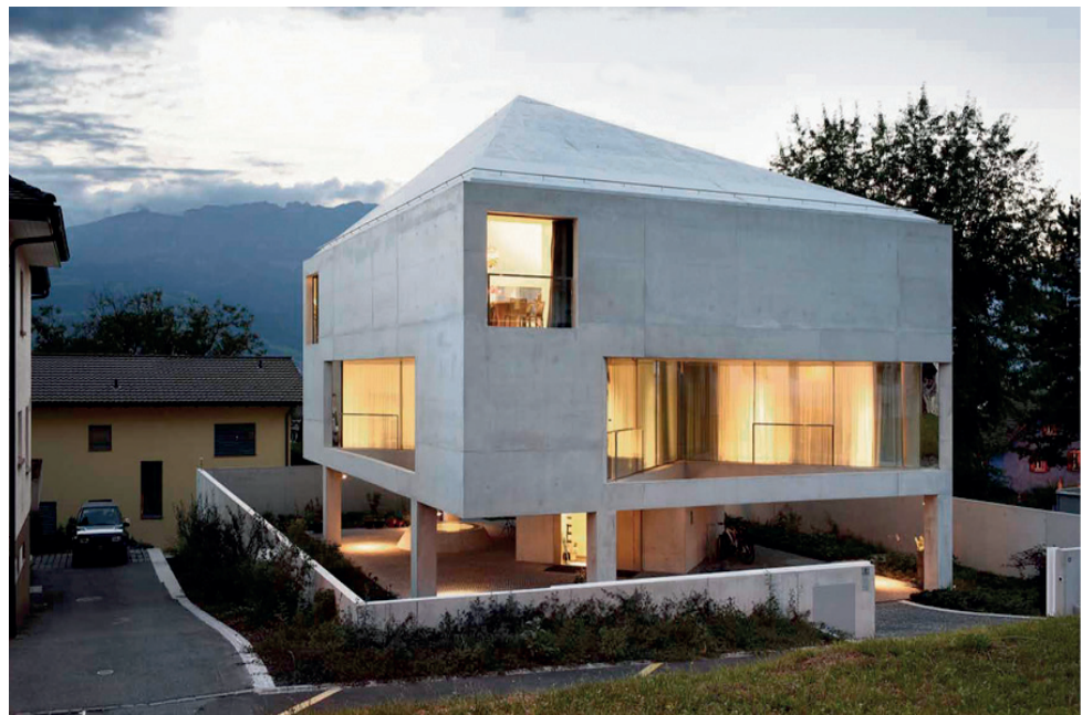
Bearth & Deplazes, La maison sur 6 piliers, Schaan, 2012
