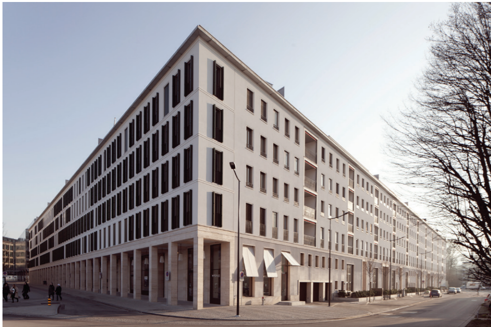
Façades Nord et Ouest
