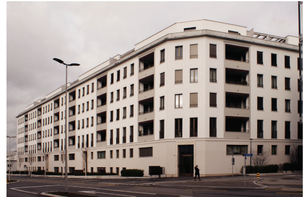
Façades Sud et Est
