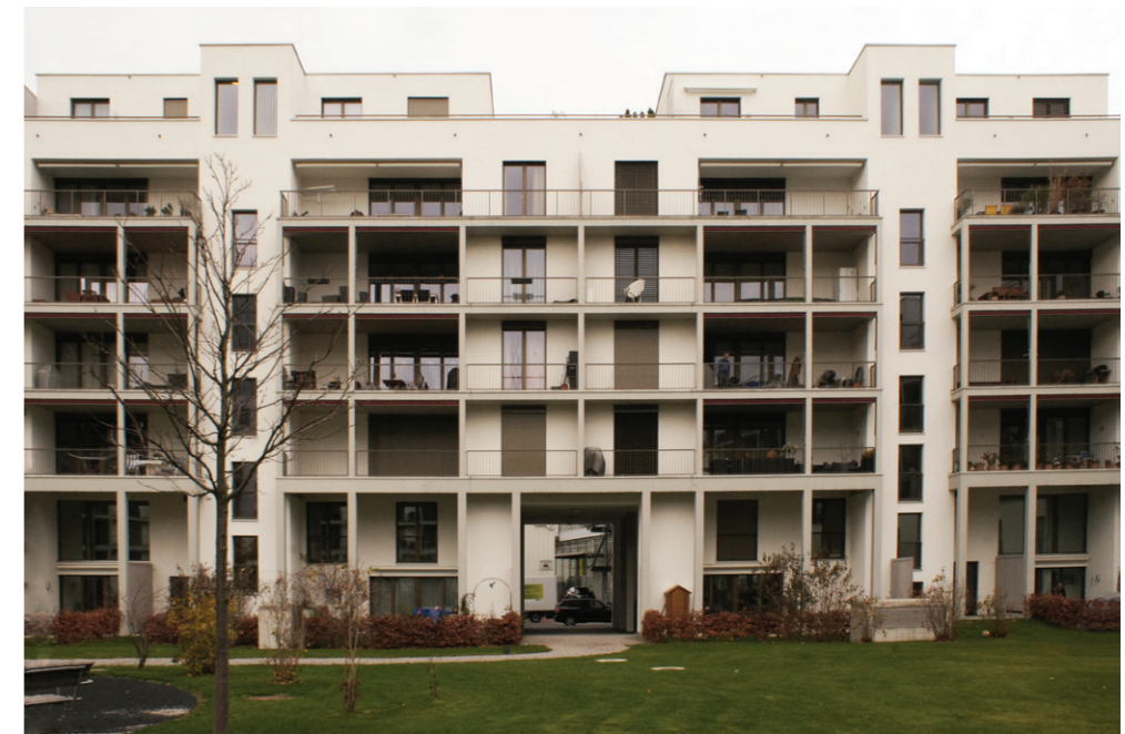
Façades Sud, Est et Ouest
