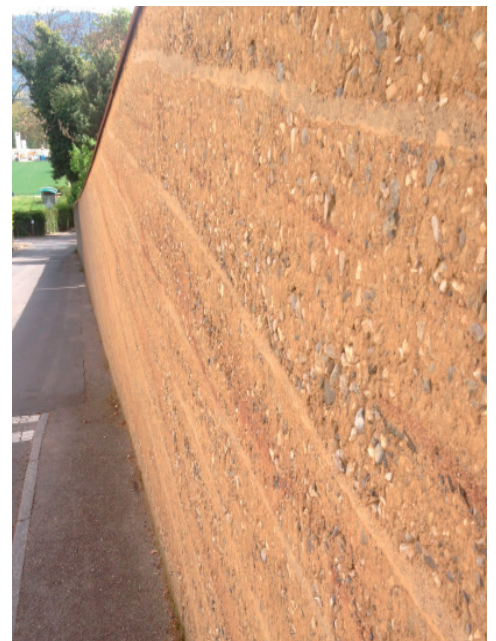
Mur côté route
