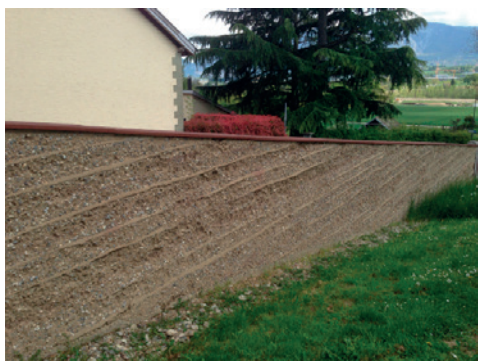
Mur côté pré
