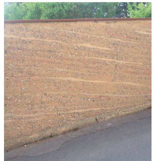
Mur côté route
