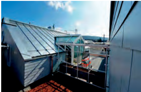
GEBÄUDE | CARETTA + WEIDMANN (2012_Zürich)
