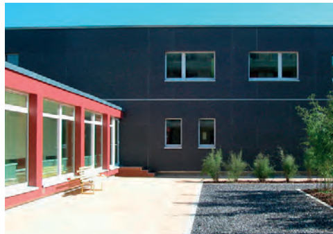
HOPITAL DE ZONE | LEZZI ARCHITECTE (2006_Nyon)
