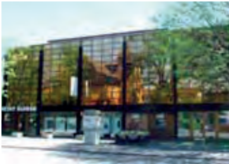
SANIERUNG ETH ZENTRUM | MML (2012_Zürchi)
