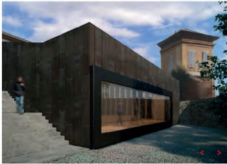
EGLISE | MAISON D'ART'CHITECTURE (2014_Neuchâtel)
