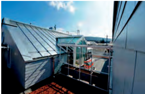
GEBÄUDE | CARETTA + WEIDMANN (2012_Zürich)
