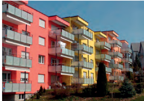
GESAMTSANIERUNG | PIETRO CORTALI AG (2005_Gossau)
