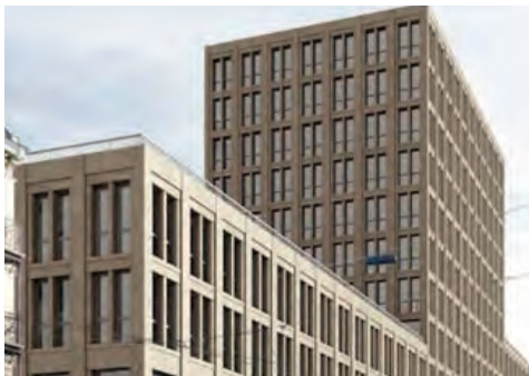
ETHZ, BATIMENT LEE | ITTEN+BRECHBÜHL (2009_Zürich)
