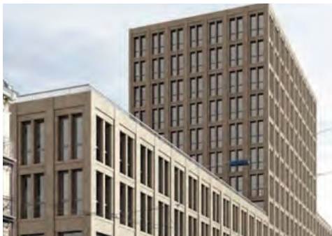
ETHZ, BATIMENT LEE | ITTEN+BRECHBÜHL (2009_Zürich)
