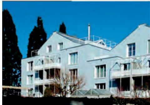
GEBAUDEHULLENSANIERUNG | HEEB (2013_Zurich)
