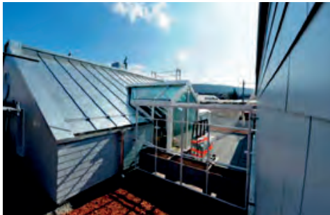
GEBÄUDE | CARETTA + WEIDMANN (2012_Zürich)
