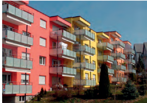
GESAMTSANIERUNG | PIETRO CORTALI AG (2005_Gossau)
