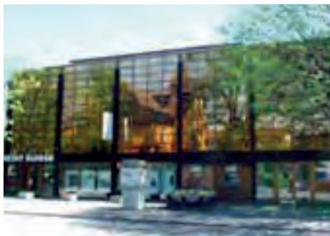
SANIERUNG ETH ZENTRUM | MML (2012_Zürchi)
