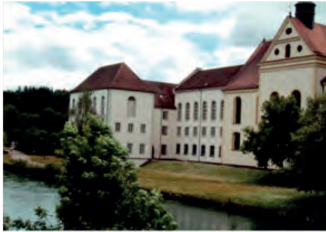
UMBAU | SCHRANZ (2013_Rheinau)
