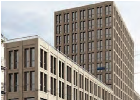
ETHZ, BATIMENT LEE | ITTEN+BRECHBÜHL (2009_Zürich)
